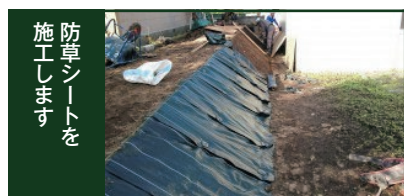
雨水で法面の土が 流されないように 転圧しながら固めます
