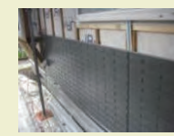
②悪い下地の交換とタイルベース張り
