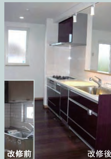
天井の下がり壁にスポットライトを取付けデザイン的に再利用。
