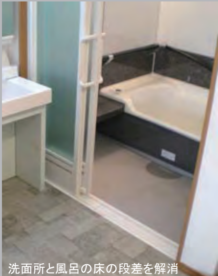
手摺と滑り止めのゴムチップパネル
