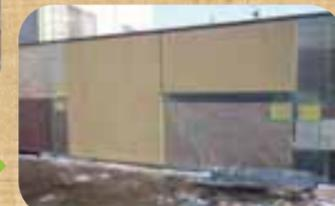
プライマーを施工の後テクスチャーでコーティングし、仕上げます。
