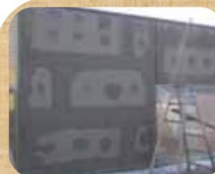
断熱パネルを施工し、ベースコートを塗ります。
