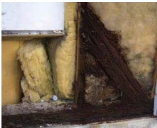
↑ 外壁の張替えの際に発覚した下地や土台部分の腐れ↓
