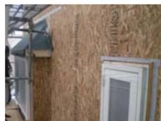
構造用パネルを張り耐震補強した上に保温性・断熱性能がUPするというセラミックパウダーを入れた塗料を塗ります。
