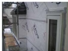
透湿防水のシートを貼り、通気胴縁、下地のサイディングを張り、仕上に乾式タイルを貼っていきます。
