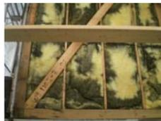
今回は外壁だけでなく、断熱材も入れ替えるため、既存の外壁を全て撤去し、断熱材を入れ替えます↓↓↓
