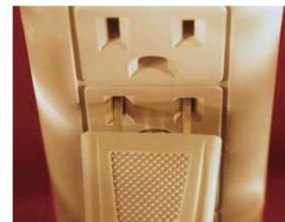
その他、冷蔵庫・テレビ・電子レンジ・エアコン・暖房器具など長期間コンセントを抜かないうえ、ホコリが溜まりやすく結露などの水気を呼ぶような場所は注意が必要です。タコ足配線など過剰な電源の使い方はそれだけ接点が増え、トラッキング火災の原因にもなり得ます。また、コンセントや電源プラグ、コードが異常に熱くなっている時はすぐに使用をやめ、専門業者に点検してもらいましょう。
